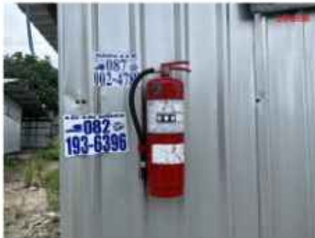
ถังดับเพลิงบริเวณพื้นที่ปฏิบัติงานที่มี ประกายไฟ
